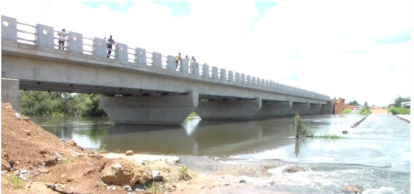
Mwonekano wa Daraja la Koga baada ya kukamilika ujenzi, Daraja hili linaunganisha Mkoa wa Katavi na Tabora.
